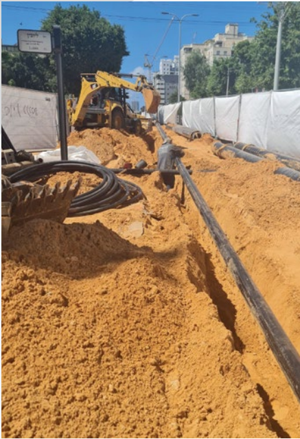
רח' אחד העם שדרוג קו מים בקוטר 16"
