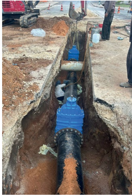
רח' קיבוץ גלויות הנחת קו מים חדש בקוטר 20"
